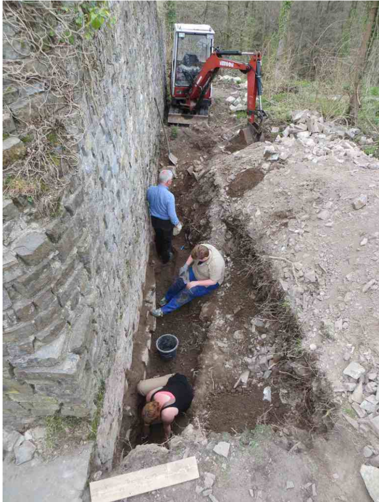
Abb. 3: Arbeitsfoto S 12 (Freilegen Palasmauern an Binnenwand)
