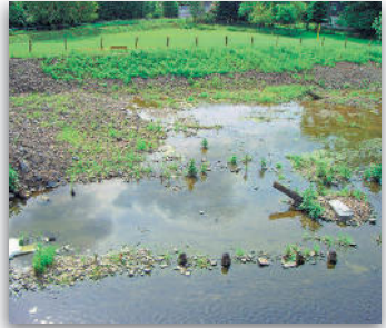
Holzreste der Olderbrücke, die je nach Bewuchs und Wasserstand noch heute manchmal sichtbar sind
