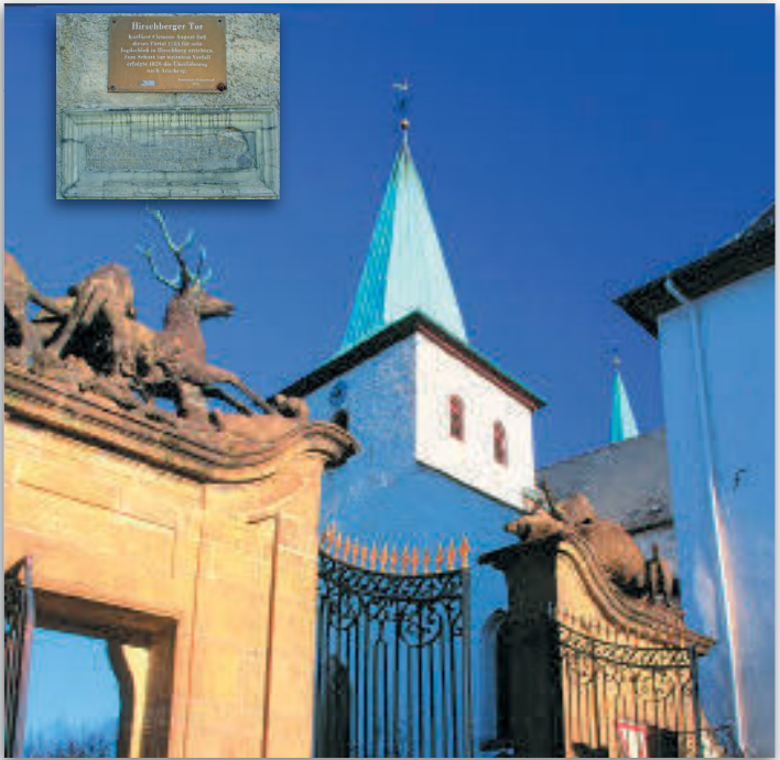
Ansicht des Turms der Propsteikirche St. Laurentius, die Urzelle des 1170 gegründeten Klosters Wedinghausen; davor das Hirschberger Tor.
