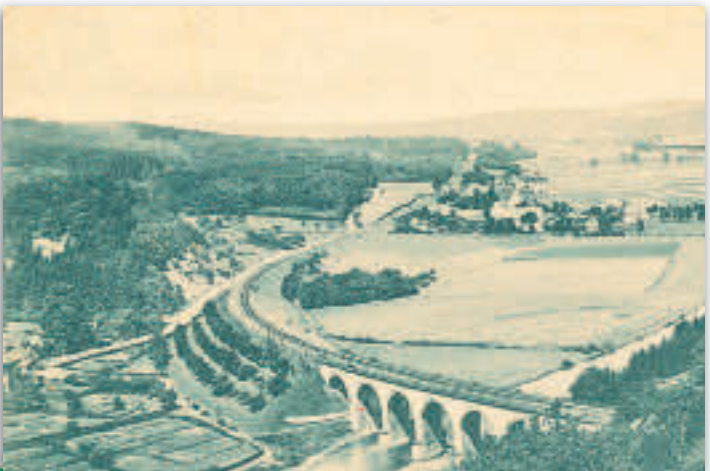
Der Eisenbahnviadukt überspannt das Ruhrtal. Rechts oben ist das Rittergut Obereimer zu sehen (Aufnahme um 1900)
