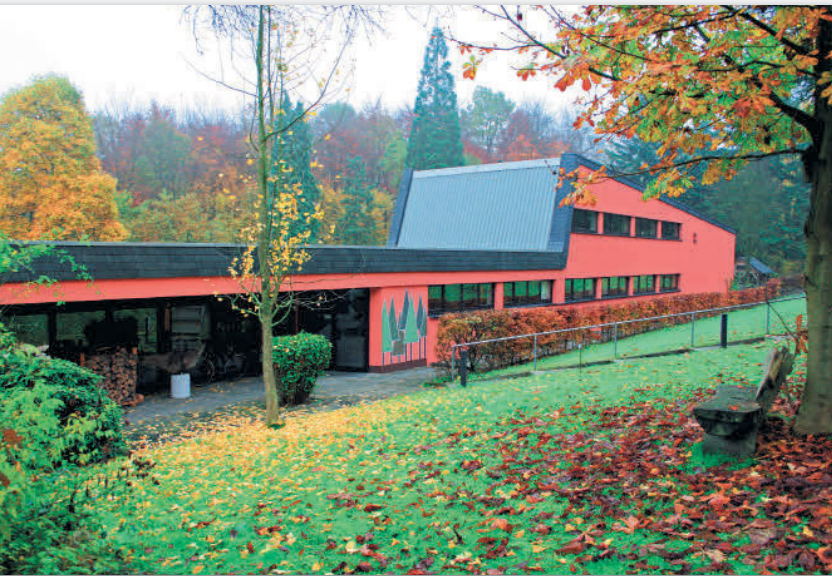
Das Jugendwaldheim Obereimer; das Gebäude wurde 1967 als Landesforstschule errichtet
